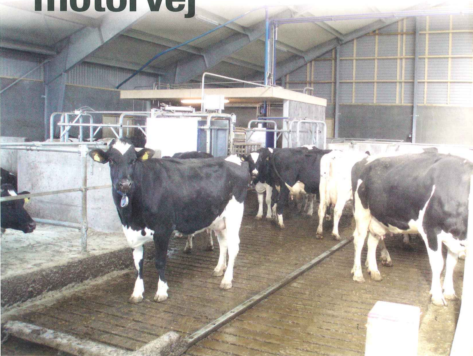
Almindelige spaltegulve i kvægstalde er ikke beregnet til trafik, men til vægten af dyrene.
